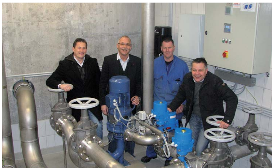
Vizebürgermeister Fritz Neu, Bürgermeister Günther Mitterer, Wassermeister Gerhard Thurner und Vizebürgermeister Johannes Moser überzeugten sich von der neuen Technik im Hochbehälter Hubangerl.
