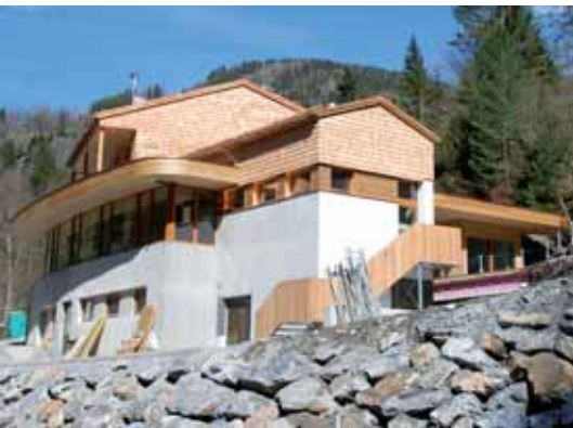
Das Gebäude ist von allen Seiten ein Blickfang und fügt sich harmonisch in die Natur.
