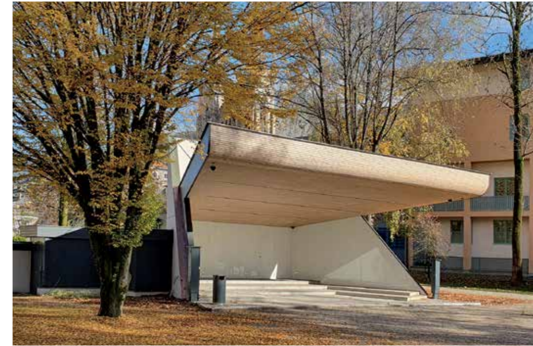
Der Musikpavillon wurde im Spätherbst fertiggestellt und hat sich schon bei etlichen Veranstaltungen bestens bewährt. Auf dem Platz davor werden vier große Schirme aufgestellt. Foto: Arch. DI G. Maier
