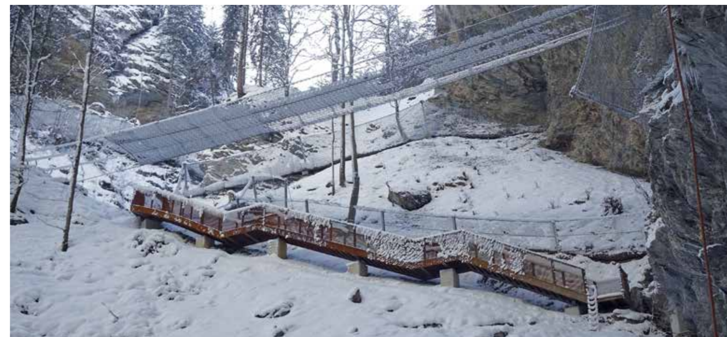
Ein Blick in die winterliche Liechtensteinklamm: Stiegenanlagen aus witterungsbeständigem Corten-Stahl führen in das Naturdenkmal. Fotos: E. Viehhauser
