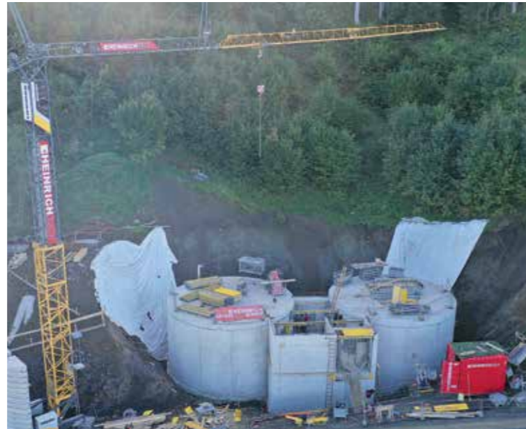
Die Behälter sind betoniert. Mitte Oktober waren die Arbeiten noch voll im Gange. Foto: M. Pfisterer
