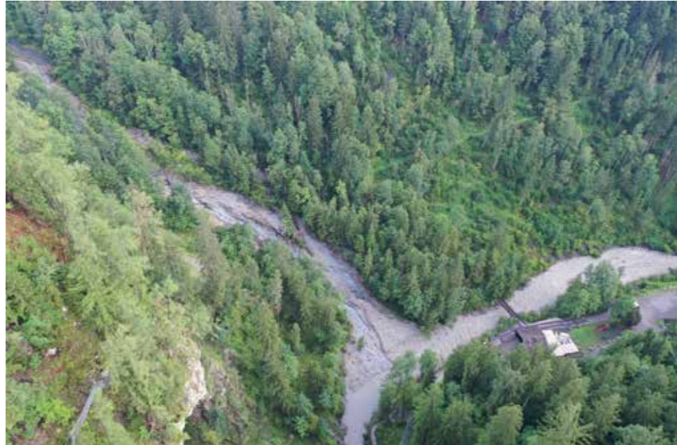
Das Eingangsgebäude war akut von einer Riesenmure gefährdet. Im Inneren des Ausflugsziels wurde unter Hochdruck gearbeitet, damit die Klamm bereits nach 4 Tagen bis zur „Helix-Plattform“ wieder freigegeben werden konnte. Foto: J. Andexer
