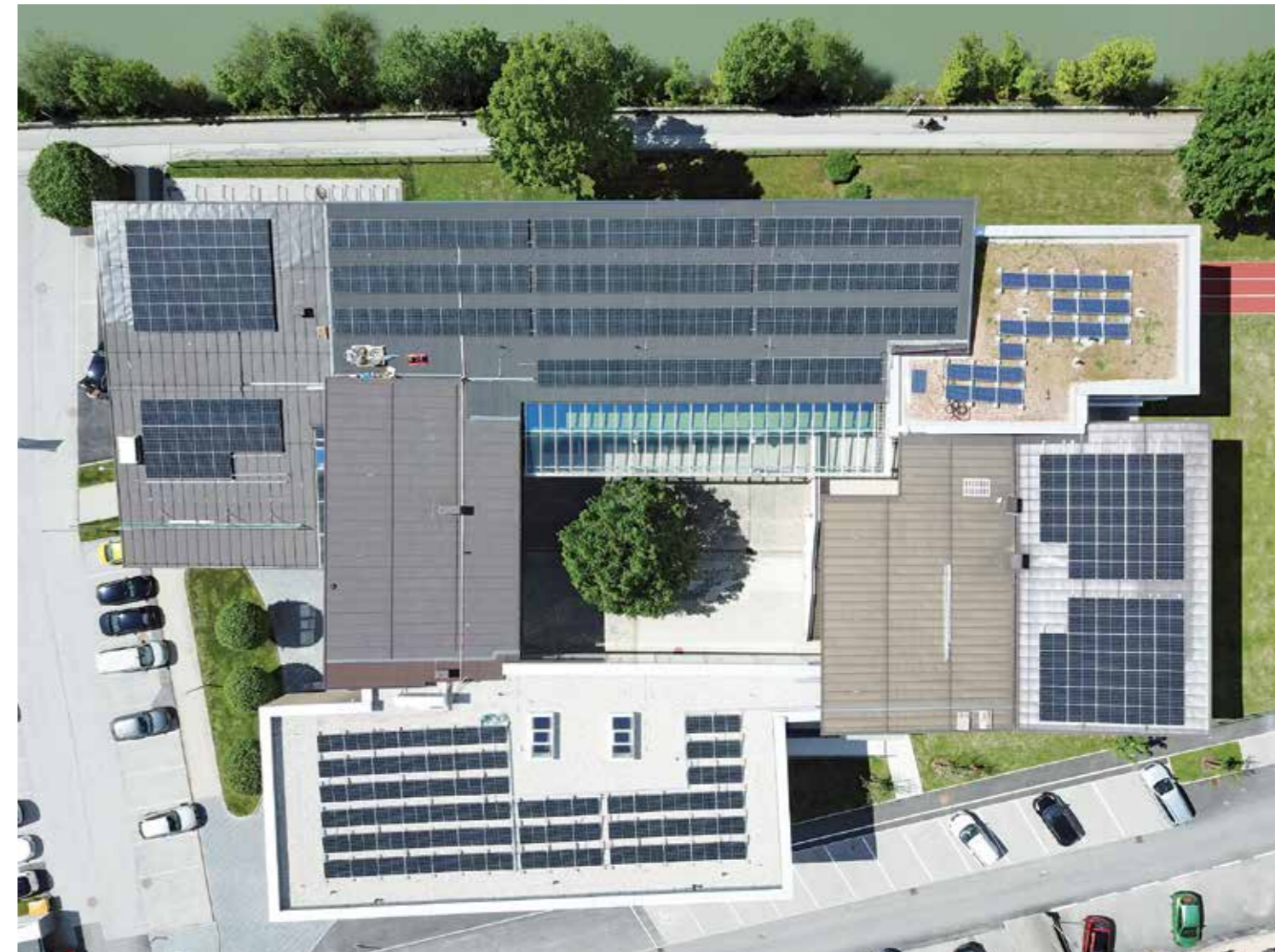
PV-Anlagen auf den Dächern der Volksschule an der Salzach – sie garantieren eine nachhaltige Energie-Zukunft. Foto: M. Schnell
