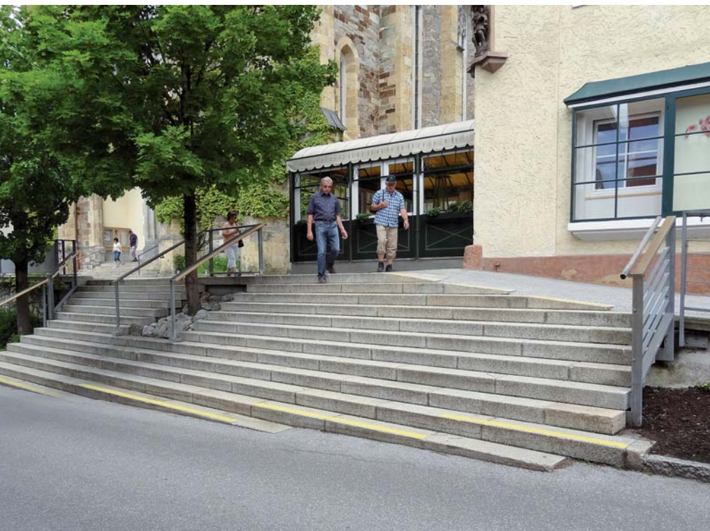
Die vor 15 Jahren errichtete Stiege zum Kirchenvorplatz wird abgetragen.
